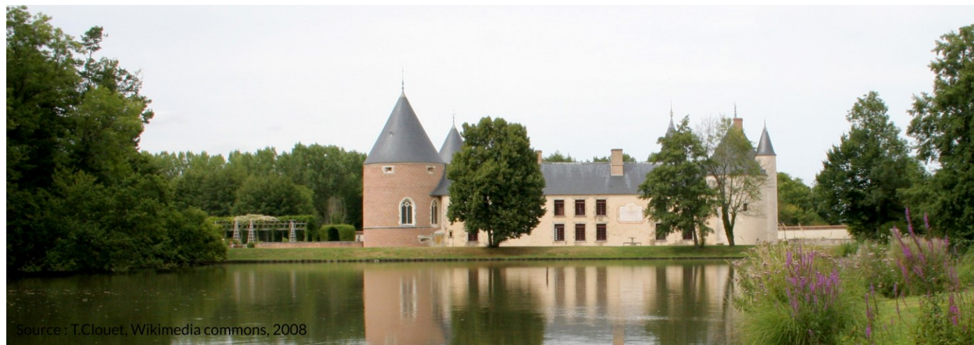
Figure 70 : Château de Chamerolles vu depuis le sud
